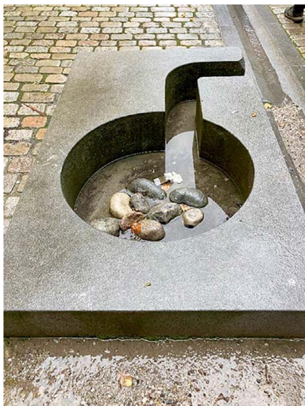
Fot. 2. Wlot do studzienki rozsączeniowej
